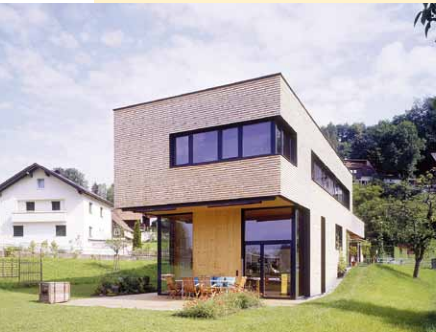
Einfamilien-Passivhaus in Wolfurt
